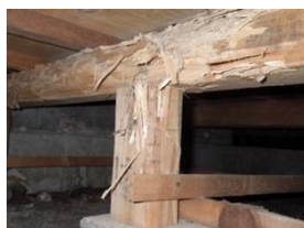
▲羽アリとなって飛び立つシロアリ ▲シロアリ被害にあった床下の木材
